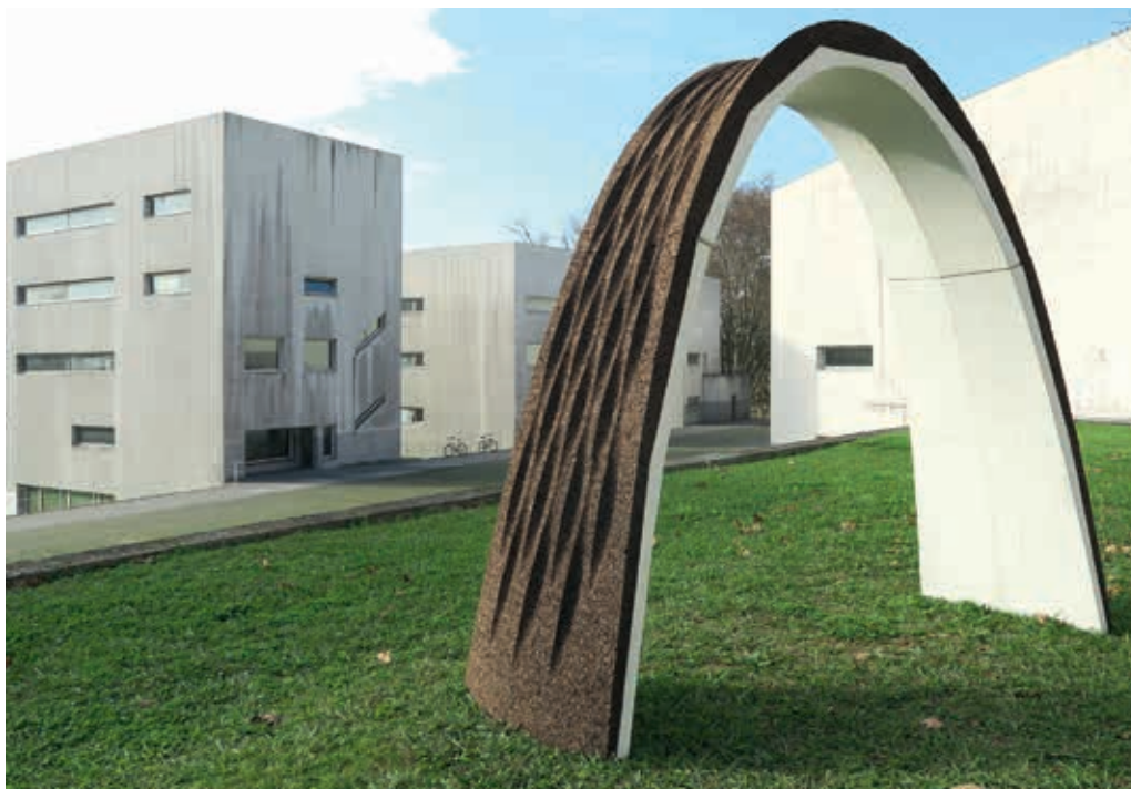
Projecto CorkCrete Arch instalado na FAUP, onde o DFL, em colaboração com a Amorim Isolamentos e Mota Engil, investigou um sistema estrutural com cortiça e betão, apto para a pré-fabricação, personalização e resolução de formas complexas (Foto: DFL)
